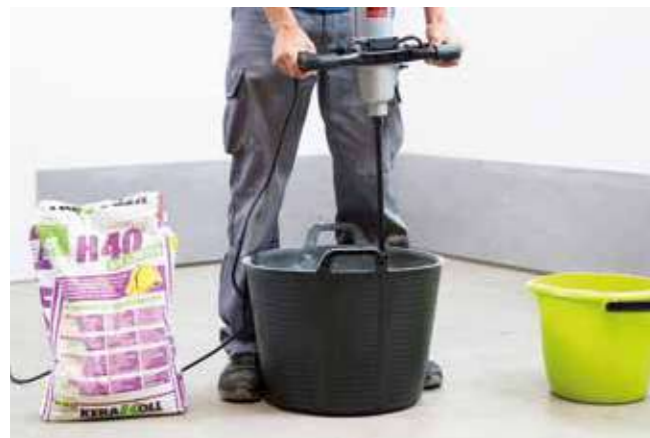
PREPARE THE ADHESIVE CEMENT · Prepara el cemento de agarre · ADHESIVE CEMENT · Cemento de agarre · Ciment à prise rapide Préparer le ciment à prise rapide · Bereiten Sie den Klebemörtel vor · Klebemörtel
