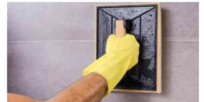
REMOVE ANY LEFTOVER GROUT AND OTHER DIRT · Elimina los residuos de junta y demás suciedad · Éliminer les résidus du joints et autres saletés · Entfernen Sie Fugenmaterialreste und andere Verunreinigungen
