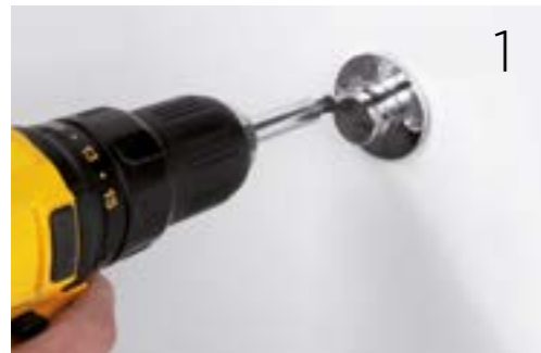
Atornillar la placa de sujeción a la pared.
