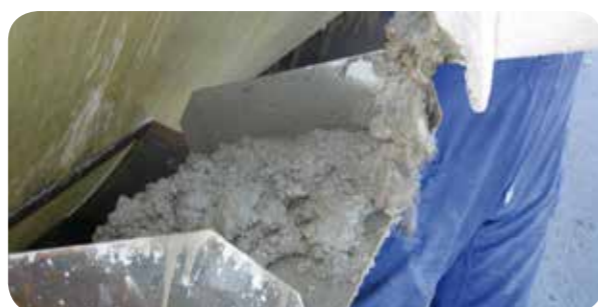
Relleno con hormigón
