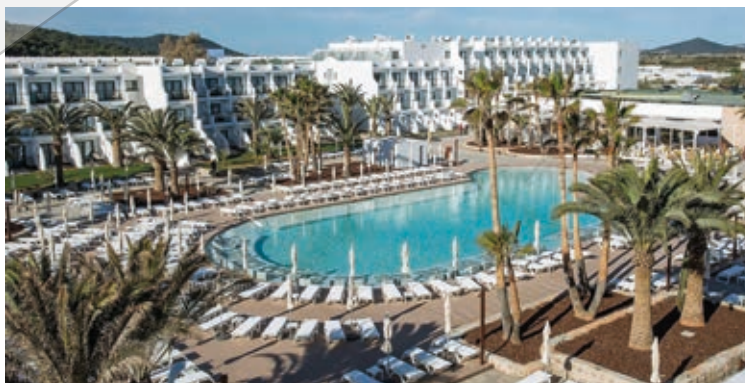
Instalación de 2 HP90W mod. 48 Hotel WHITE ISLAND RESORT (Ibiza)
