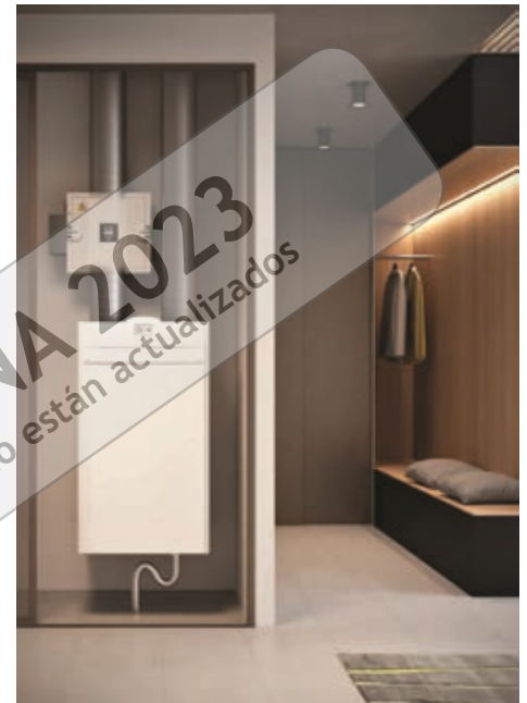
Tipo de instalación del CRYSTALL ROUND en un recuperador de calor vertical ENY PRO SP
