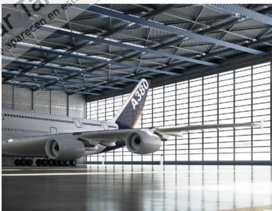
Instalación de paneles DUCK STRIP en las naves de AIRBUS.
