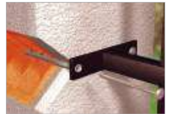
Fijación con taco
