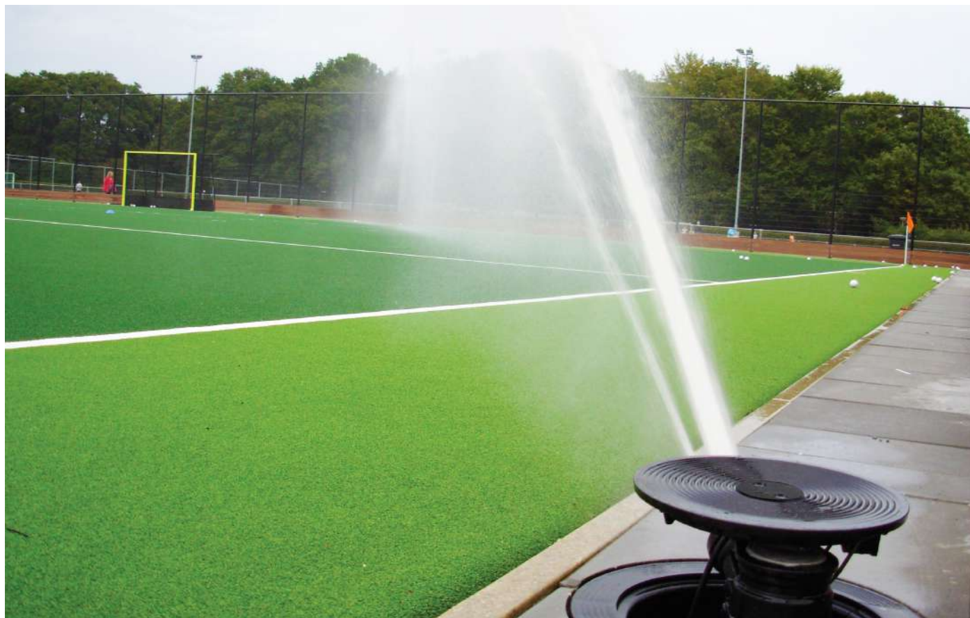
Cañón PERROT VP3 en funcionamiento.
